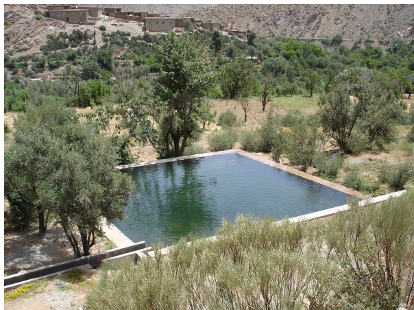
Séguia (canal) améliorée et bassin collecteur d'eau dans la province d'Al Haouz (PDRZMH)
