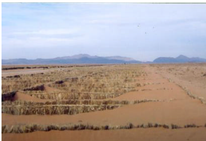
Fixation mécanique des dunes au sud de Bouarfa, oct 2001.
