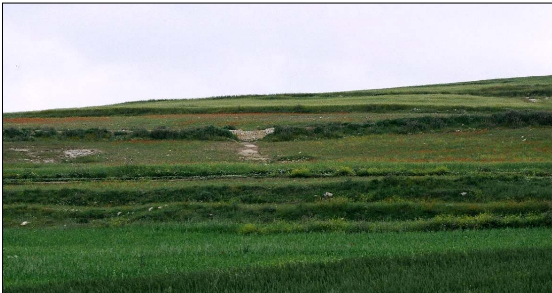
Photo 5. Aménagement sur une banquette d'un seuil déversoir en pierres sèches non cimentées Source: Salah Rouchiche, consultant FIDA
