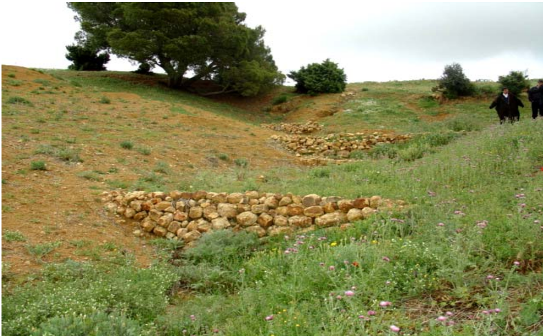
Photo 1. Exemple de travaux de CES Source: Moncef Kouidhi, consultant FIDA
